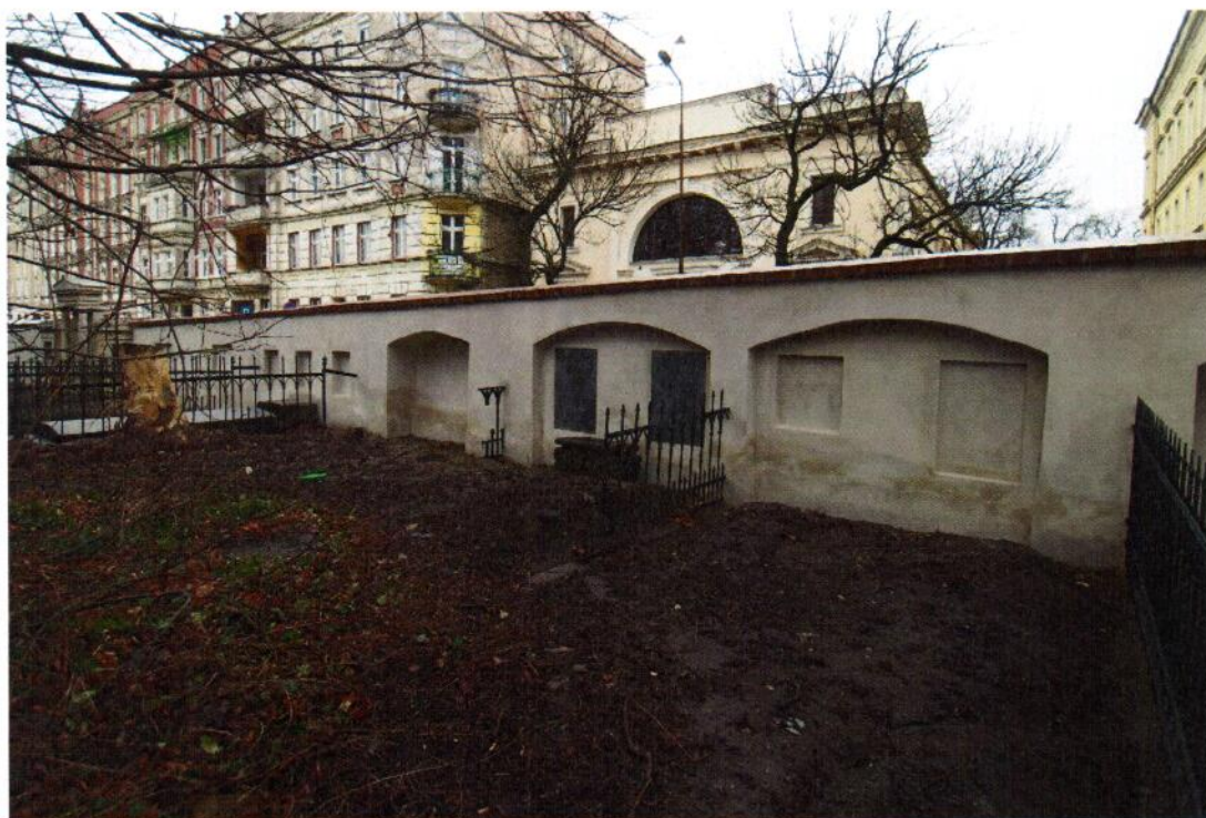
FOT.89. ŚWIDNICA, CMĘTARZ PRZY KOŚCIELE POKOJU, KWATERY PRZY MURZE WSCHODNIM
