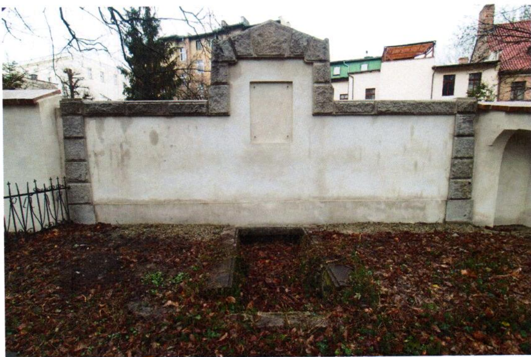
FOT.14. ŚWIDNICA, CMĘTARZ PRZY KOŚCIELE POKOJU, KWATERY PRZY MURZE ZACHODNIM
