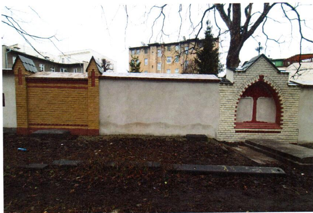
FOT.11. ŚWIDNICA, CMĘTARZ PRZY KOŚCIELE POKOJU, KWATERY PRZY MURZE ZACHODNIM
