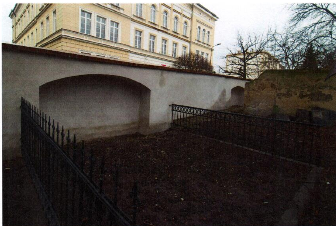
FOT.90. ŚWIDNICA, CMĘTARZ PRZY KOŚCIELE POKOJU, KWATERY PRZY MURZE WSCHODNIM
