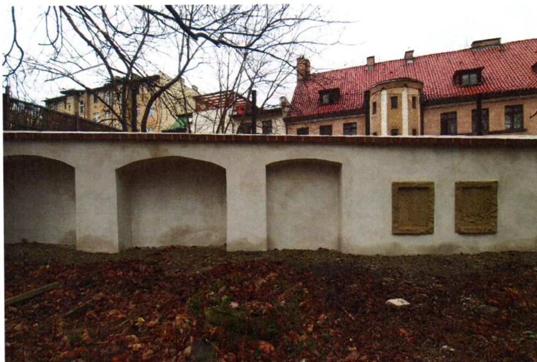
FOT.19. ŚWIDNICA, CMENARZ PRZY KOŚCIELE POKOJU, KWATERY PRZY MURZE ZACHODNIM
