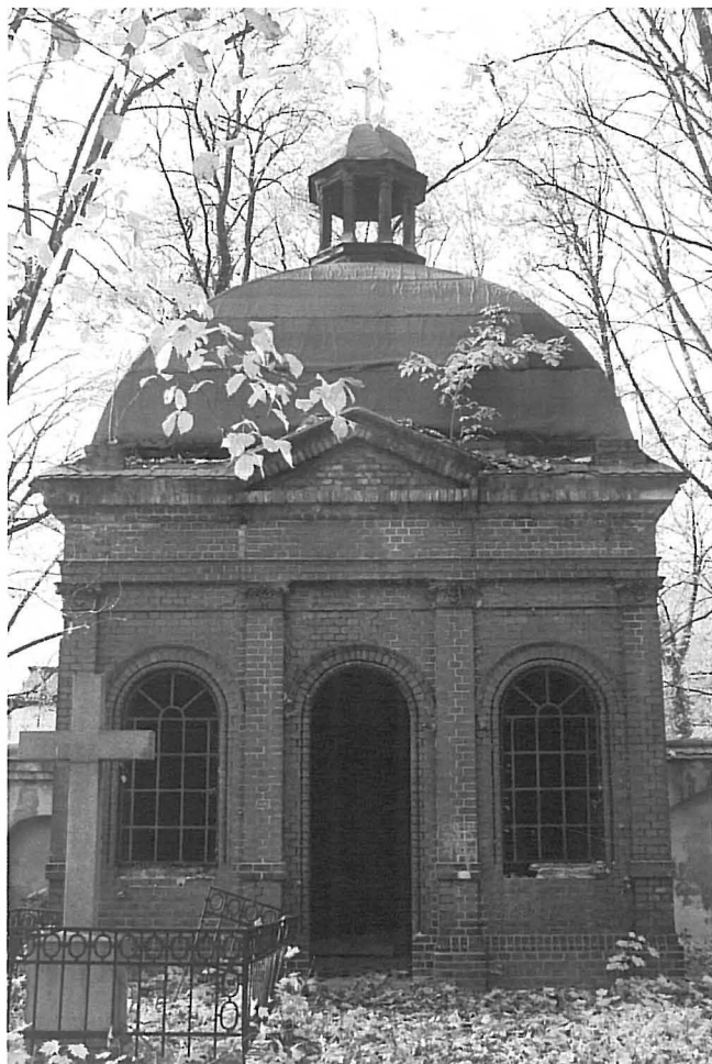
Fot.1. Kaplica III, widok ogólny od frontu.
