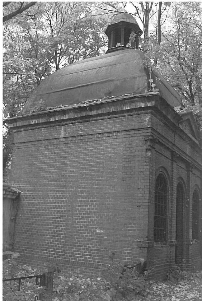
Fot.2. Kaplica III, widok ogólny na ścianę południową.
