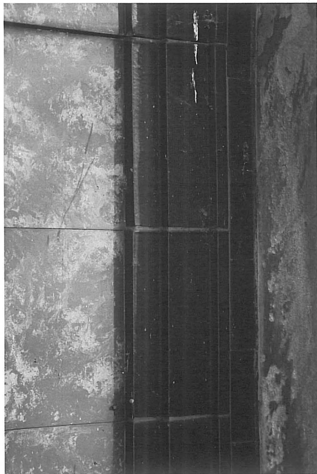
Fot.20. Kwatera N-15, płytki ceramiczne, detal.
