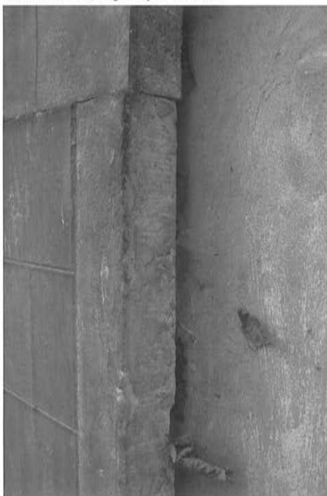
Fot.62. Kwatera N-11. detal okładziny muru.
