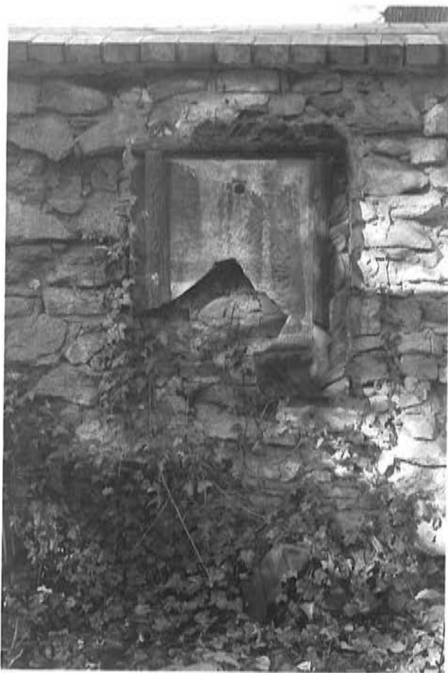
Fot.47. Kwatera N-2, obramienie płyty inskrypcyjnej.
