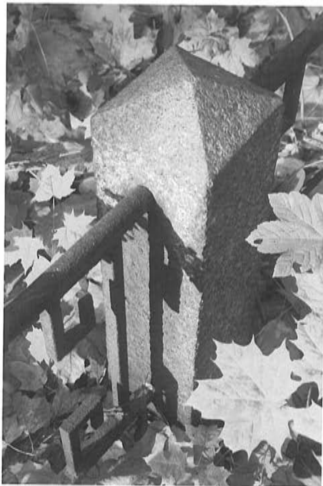
Fot.24. Kwatera W-6, detal - ogrodzenie.
