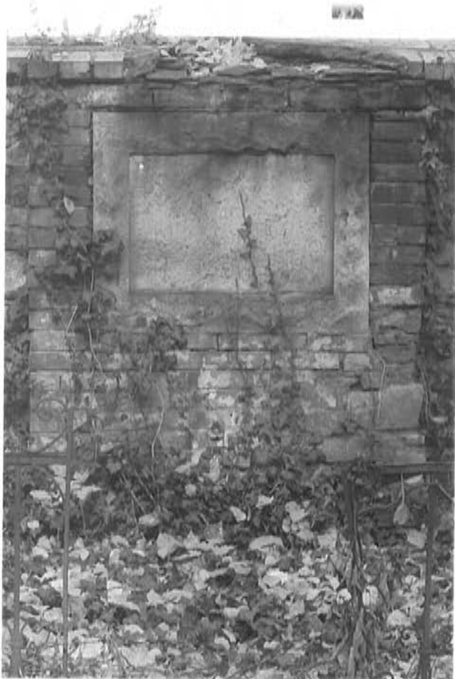
Fot.45. Kwatera N-1, obramienie płyty inskrypcyjnej.
