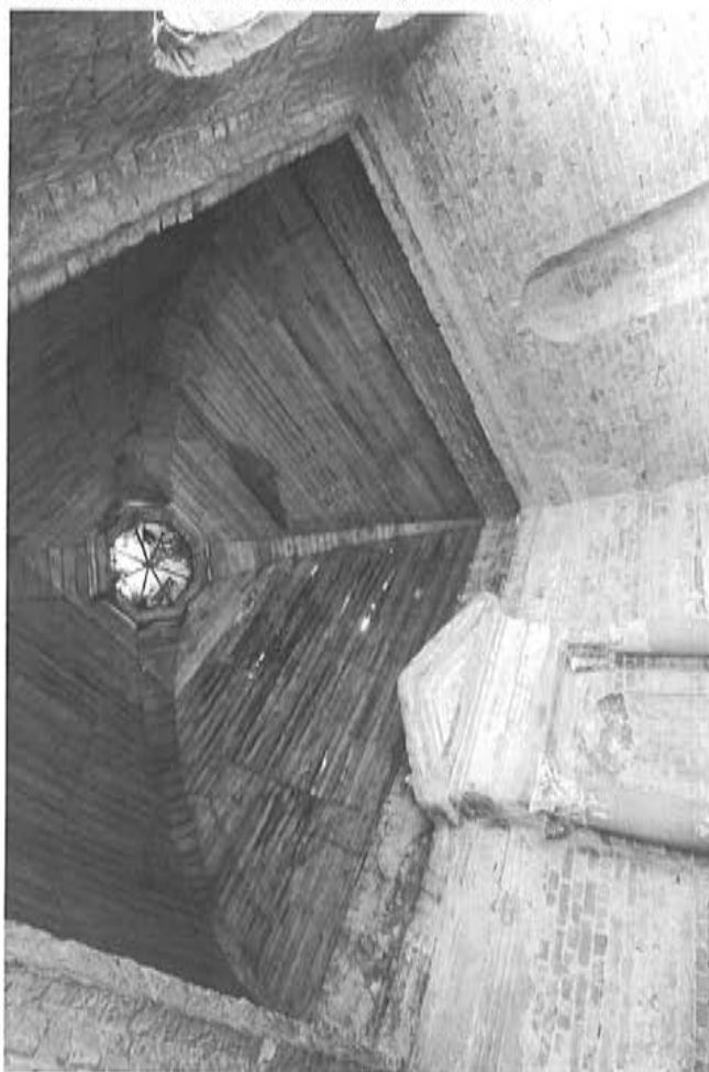
Fot.81. Kaplica III, drewniana konstrukcja kopuły.
