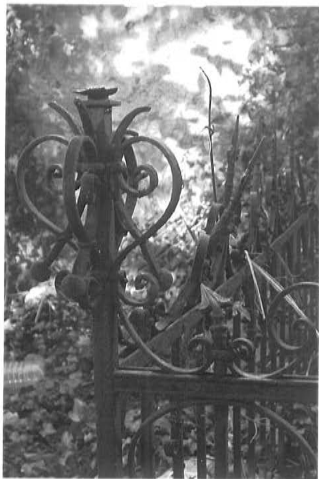
Fot.46. Kwatera N-1, detal ogrodzenia.
